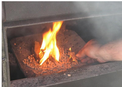
Рис. 6 Ручной розжиг топлива.
